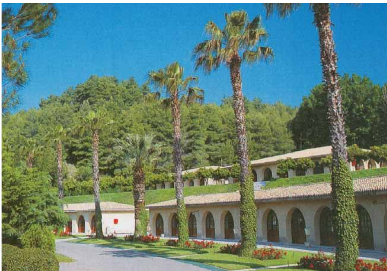
Nastanitveni objekti Akademije v Olimpiji, Grčija (fotografirano pred požarom pred nekaj leti, ki je poškodoval tudi Akademijo).
